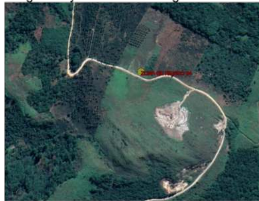
Imagen 22 y 23: zona de riesgo 04
